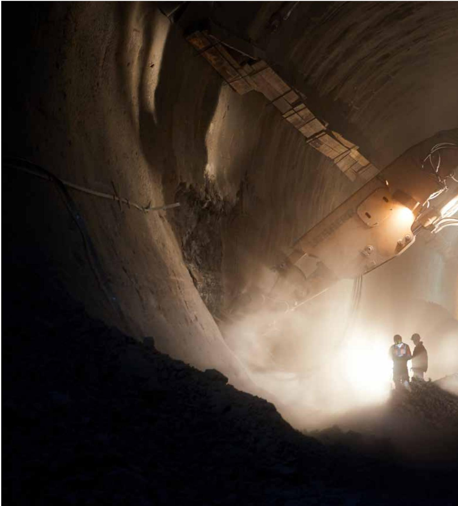
Mehr als drei Millionen Kubikmeter Ausbruchmaterial wurden bislang beim Bau des Fildertunnels und der Zuführung Ober-/Untertürkheim abgeführt. Rund um das Mega-Projekt Stuttgart 21 realisiert die PORR in einer ARGE insgesamt mehr als 30 km Tunnel in zwei Bauabschnitten. Die größte Herausforderung liegt im optimalen Materialeinsatz: Die Arbeiten am Anhydrit-Gestein müssen absolut trocken erfolgen. Dazu setzt die PORR einen eigens patentierten Spezialmörtel ein.
