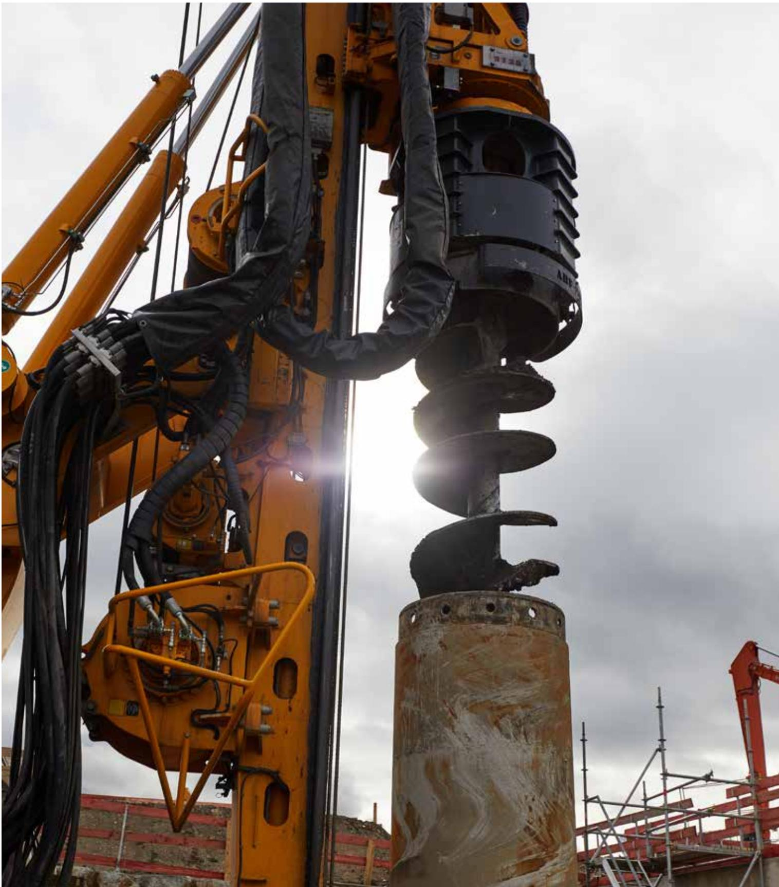
Auf innovative Spezialbohrwerkzeuge setzt die PORR bei der Baugrube für eine Bahnbrücke über die Autobahn A8 – die Anschlussstelle Wendlingen in Baden-Württemberg, um den alten Betonschutt zu beseitigen. LEAN-Management-Methoden ermöglichen eine transparente und ressourcenschonende Koordination und das effiziente Zusammenspiel der verschiedenen Gewerke.
