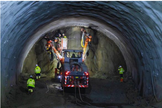
Rascher und effizienter: LEAN sorgt für bessere Zusammenarbeit © PORR
