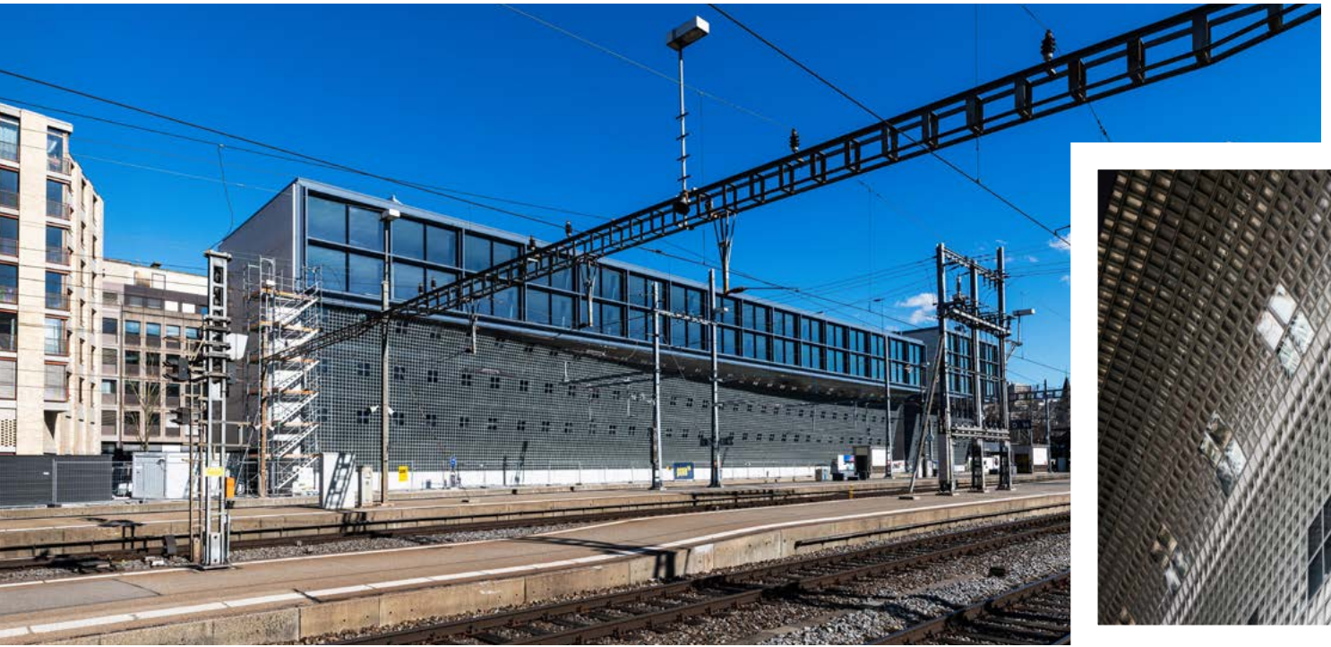
Das Büro- und Geschäftshaus «Gleisarena» an der Zollstrasse in Zürich zeichnet sich durch eine Glasbausteinfassade aus.
