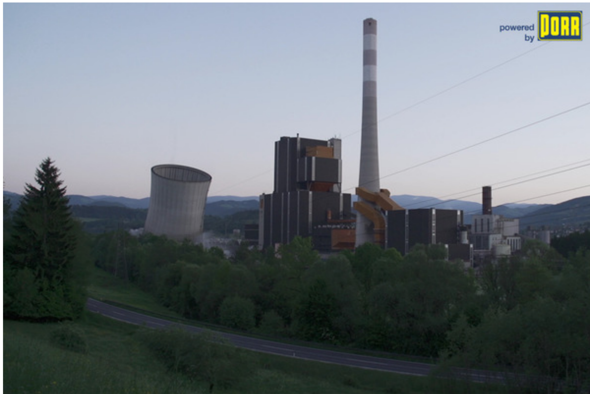
Foto: Einsturz des Kühlturms
