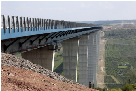
Hochmoselbrücke - B 50neu © LBM Trier
