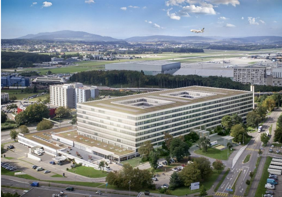
Bildunterschrift: Der Balsberg in Kloten © Albert J. EISELE Architekten & Ingenieure
