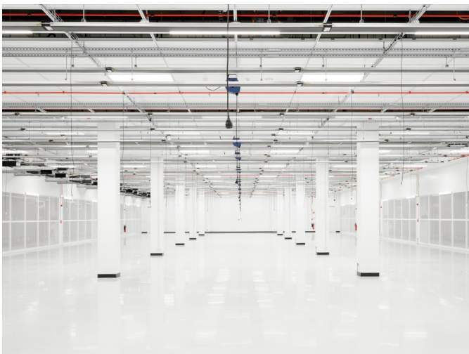
Der Bau von Rechenzentren ist mit besonderen Anforderungen verbunden © PORR
