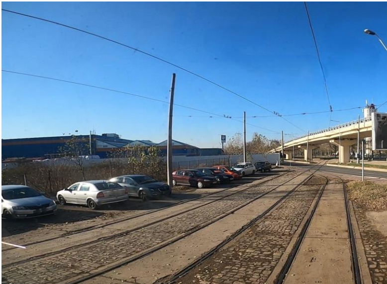
Železniční infrastruktura stárně. - PORR ji kompletně zrekonstruuje. PORR ©
