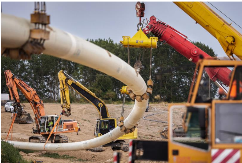
In nur 25 Monaten errichtet die PORR den 34 km langen Abschnitt der Gaspipeline © PORR
