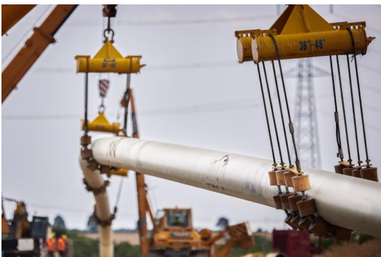
Die Hochdruck-Erdgasleitung hat einen Durchmesser von 1 m © PORR
